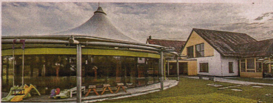
Bei der Kita in Unterferrieden hat es bereits einen versuchten Einbruch gegeben.
